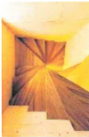
Die Treppenstufen laufen wie Tortenstücke zu einem Punkt zusammen. Eine klassische Spindel gibt es nicht.
